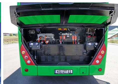
Im Heck sitzt ein Großteil der E-Technik
